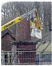
Dieser alte Schornstein musste weichen.
