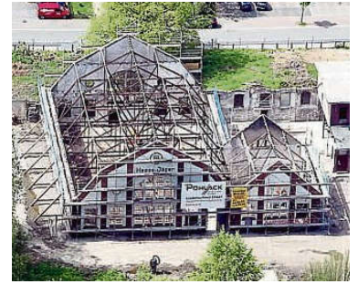
Nur ein Gerüst gab dem entkernten Bau zeitweiliges Halt.
