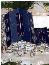
Ein neues Dach dank der Stiftung Denkmalschutz.
