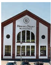
Schöne Fassade, viel dahinter.
