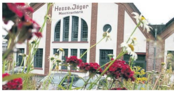
Nach zweimonatigem Dornröschenschlaf wieder zum Leben erwacht: das „Schneckenhaus“ an der Brückenstraße. Im Mai ist dort der Betrieb neu angelaufen.
